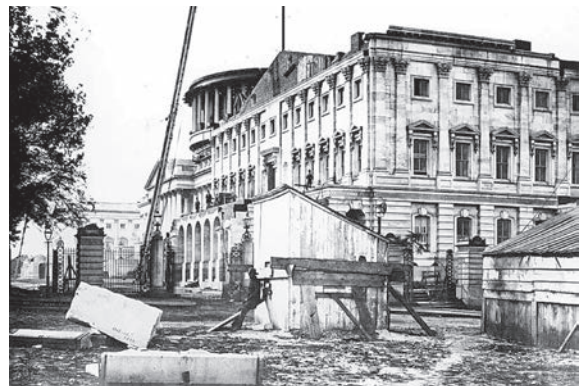
Công trình xây dựng tòa nhà Quốc Hội Hoa Kỳ (1859)
