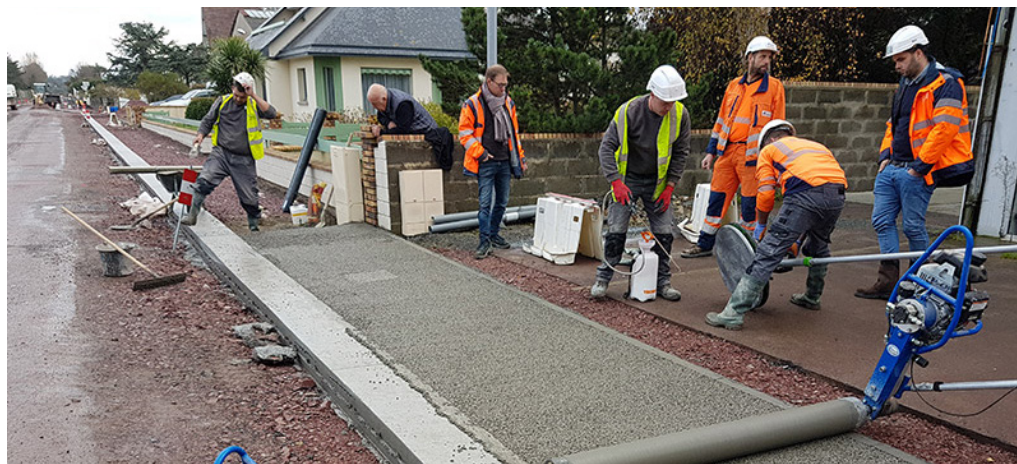
Trải thảm bê tông thấm nước, chống ngập
