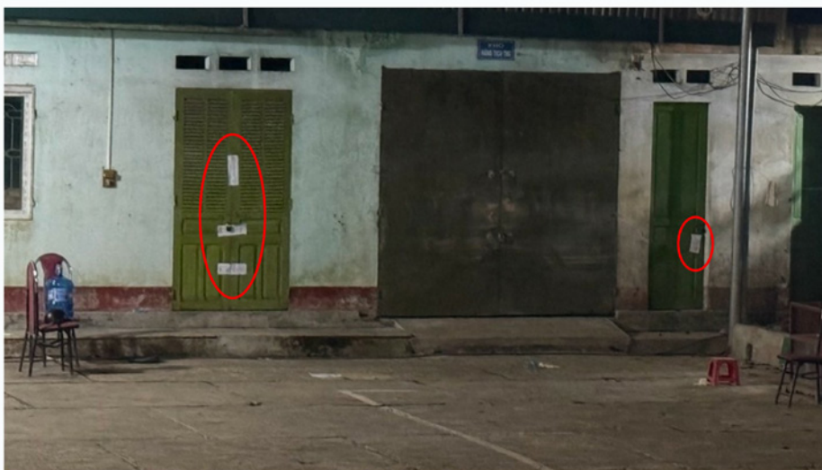
Khu nhà được cho là nhà ăn, bếp có cánh cửa màu xanh đang được niêm phong trong trụ sở cũ của Đội Quản Lý thị trường số 4. ẢNH: NHÓM PV
