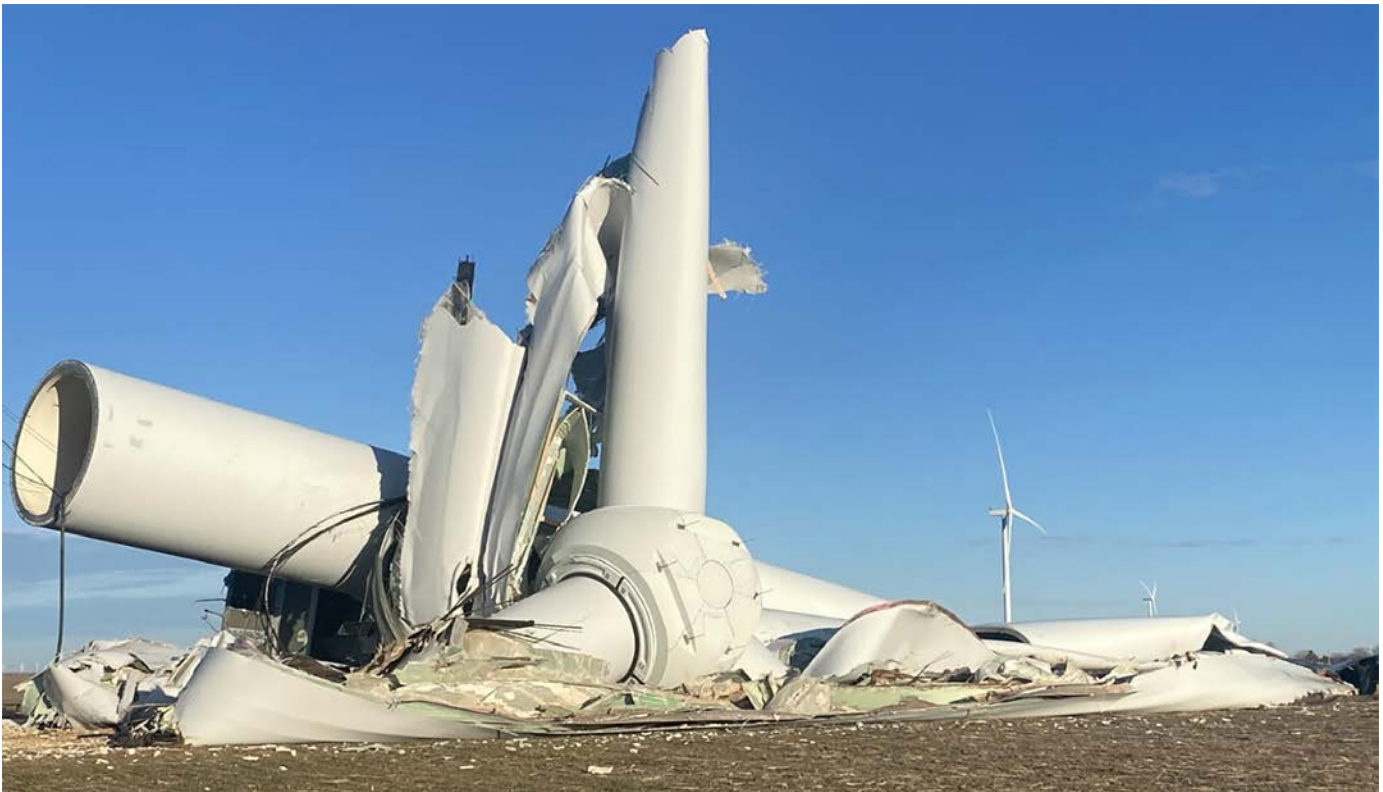
Một tua-bin gió bị sập. Mỗi năm có khoảng 4,000 tua- bin gió bị gãy, đổ, cháy...
