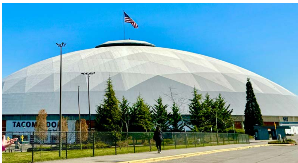
Tacoma Dom, một trong những công trình mái vòm bằng gỗ lớn nhất thế giới. Ảnh: TT
