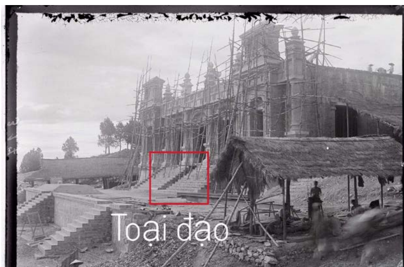
Cung Thiên Định lúc đang xây dựng
