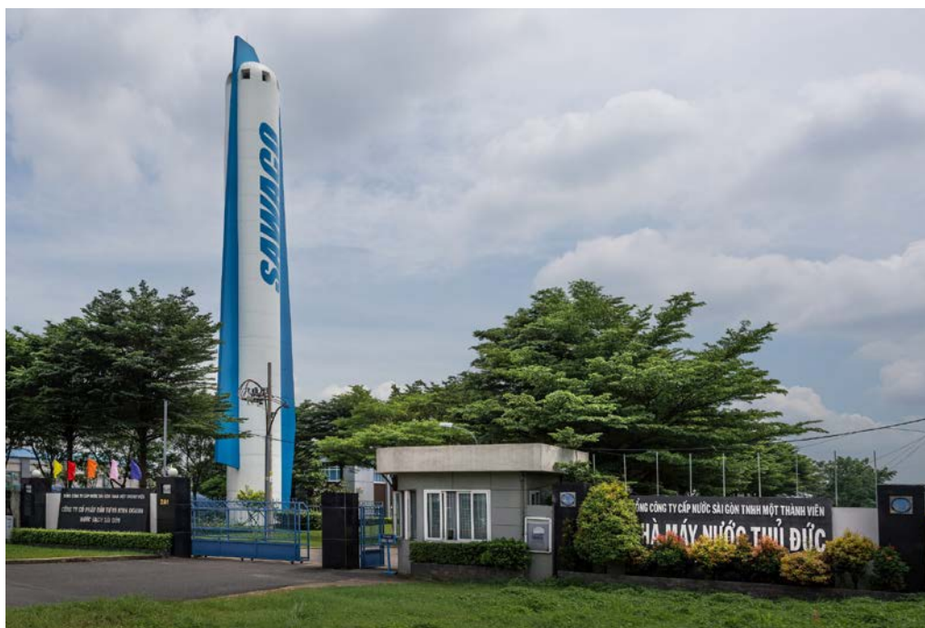
Nhà máy nước Thủ Đức
