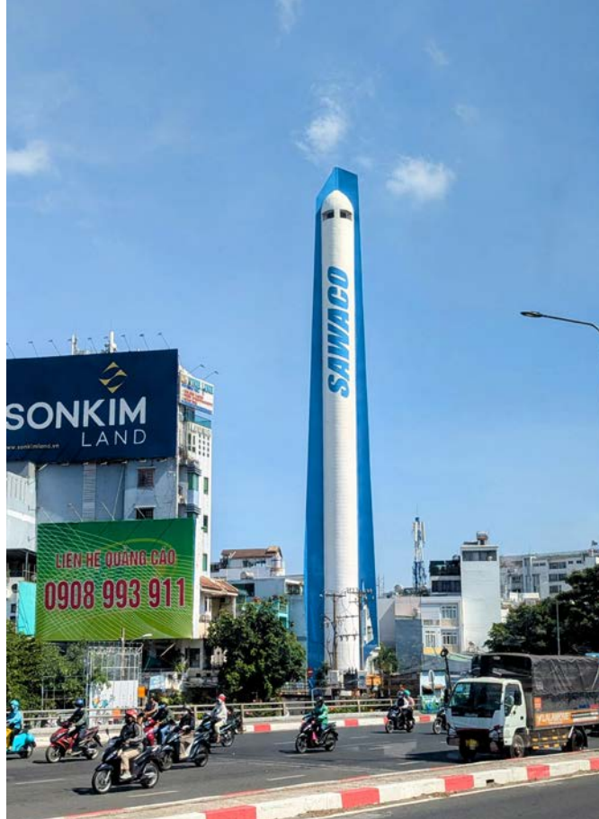
Trụ Tháp điều áp ở Nhà máy nước Thủ Đức nhìn từ trên metro
