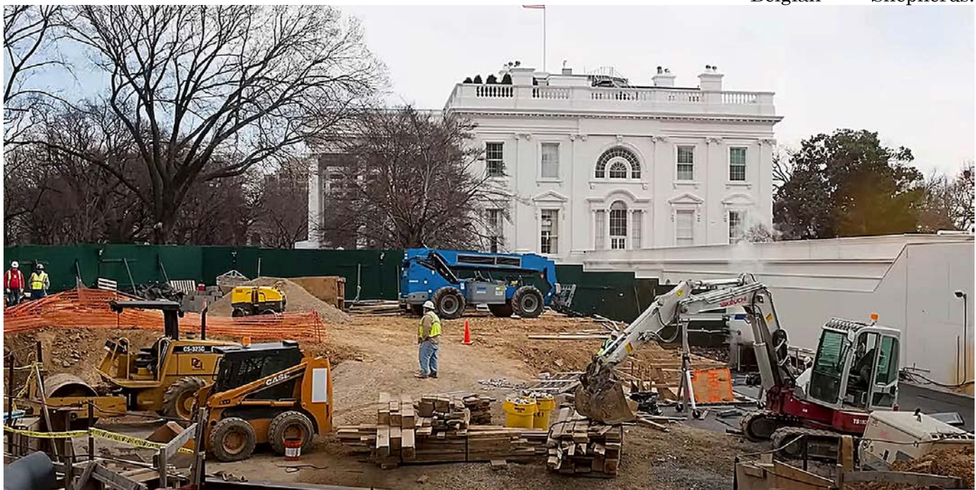
Hệ thống đường hầm thoát hiểm mới được xây dựng chớp nhoáng trong 2 năm, hoàn tất năm 2012
