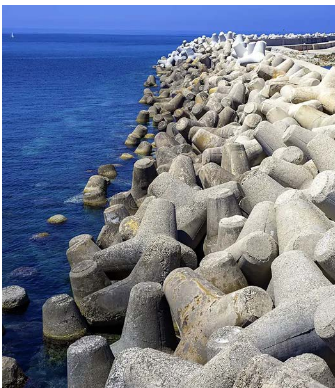
Các khối bê tông 4 chân tetrapods làm đê chắn sóng
