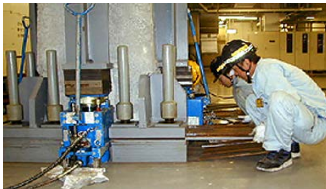
Các kỹ thuật viên nâng hạ nền phi trường Kansai bằng kích thủy lực (hydraulic jacks)
