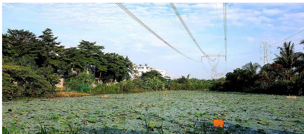
Một cái bầu trên đường ngang Phạm Thế Hiển
