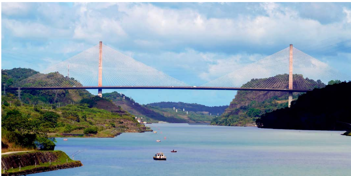
Cầu Puente Centenario
