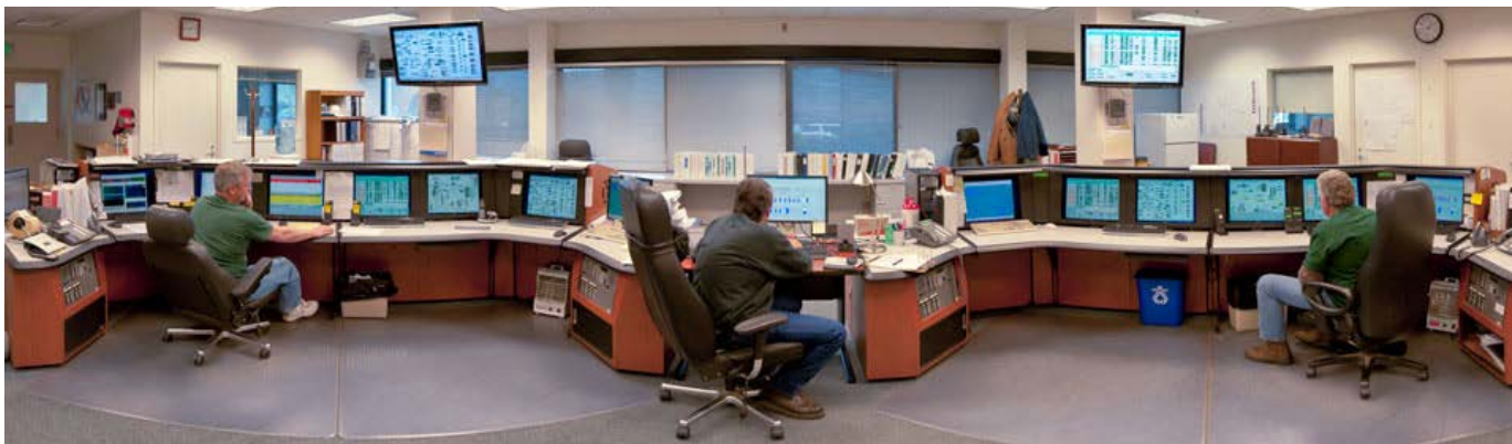
Phòng điều hành một nhà máy địa nhiệt điện
