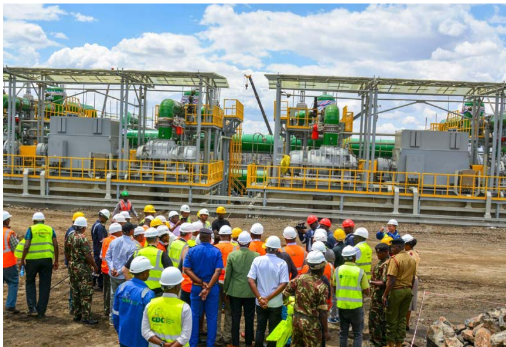
Một nhà máy địa nhiệt điện có công suất 35 MW vừa hoàn thành tại Kenya.
