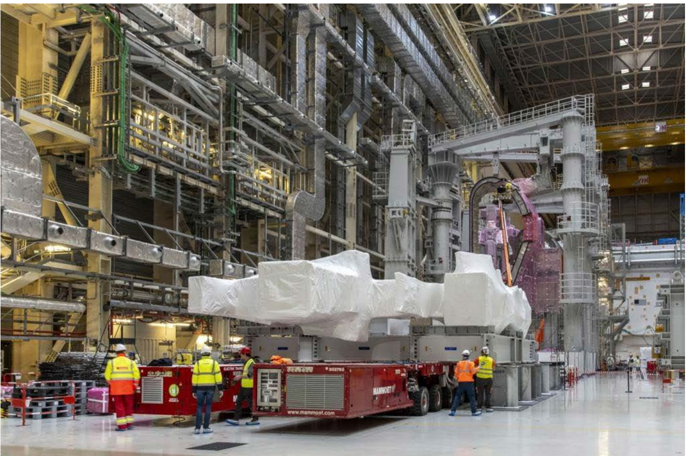
Những thiết bị kỹ thuật được gửi đến từ nhiều quốc gia để xây dựng lò nhiệt hạch ITER (NGUỒN ẢNH: WWW.ITER.ORG)
