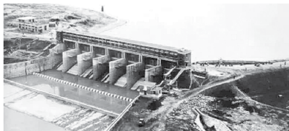
Đập Bản Kiều thuộc tỉnh Hà Nam, TQ trước khi bị vỡ.
