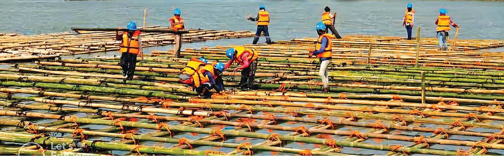
Tại công trường xây dựng cao tốc
