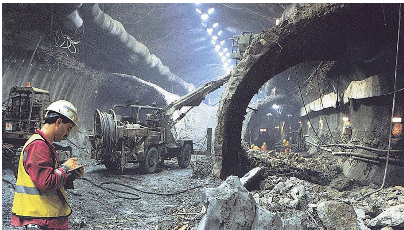
Công nhân làm việc trong một đường hầm đang xây dựng
